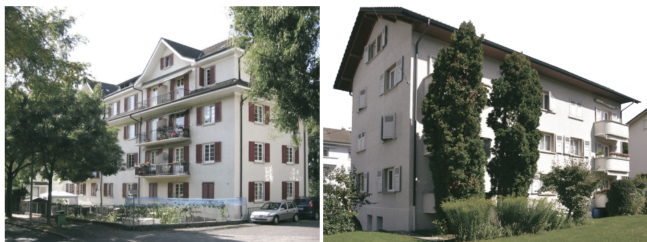
Fig. 24 et 25 de gauche à droite. Bâtiment construit en 1931 à Vevey, bâtiment construit en 1947 à Fribourg.
