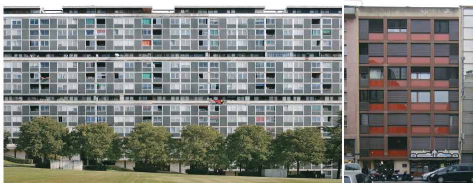
Fig. 38 et 39 de gauche à droite. Bâtiment construit en 1960 à Genève, bâtiment construit en 1980 à Genève (étude de cas 09).
