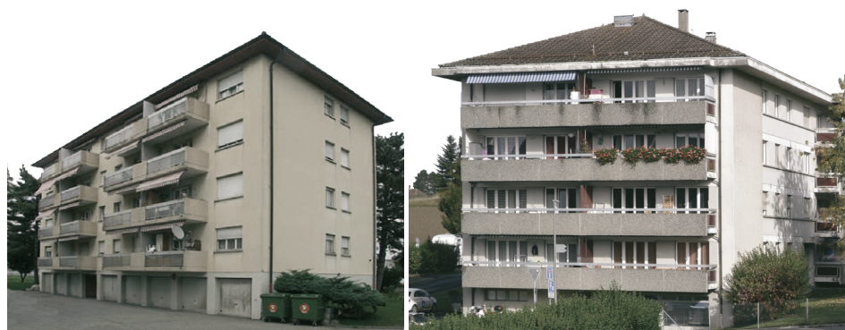
Fig. 35 et 36 de gauche à droite. Bâtiment construit en 1972 à Denges, bâtiment construit en 1972 à Cossonay (étude de cas 06).
