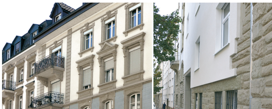
Fig. 45 et 46. À droite, les conséquences d'une isolation périphérique non réfléchie sur les caractéristiques architecturales d'un bâtiment. À gauche, un autre bâtiment montrant les caractéristiques architecturales perdues dans le second.
