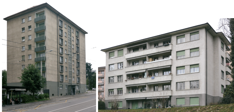
Fig. 29 et 30 de gauche à droite. Bâtiment construit en 1955 à Fribourg, bâtiment construit en 1960 à Lausanne (étude de cas 04).
