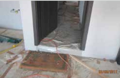
Limite de la zone chauffée © Service de l'énergie du canton de Fribourg
